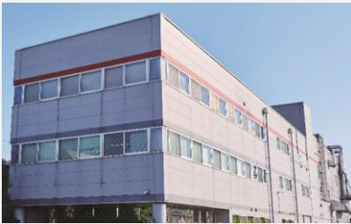
事業譲受 ベーカリー工場 (2024年4月稼働)
